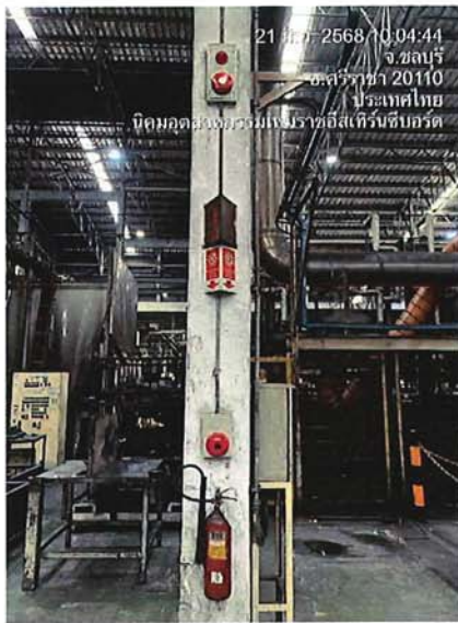
ภาพที่ 20 ระบบแจ้งเหตุเพลิงไหม้
